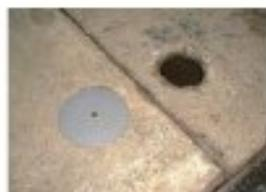
樹脂製のため、車が通過しても傷がせず、サビの心配もありません。地下の作業員への落下物も防ぎます。
