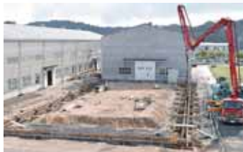
9.28 支柱基礎工事
