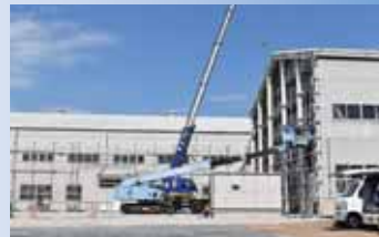
10.16 工場繋ぎ面壁外し
