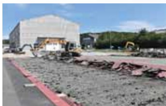
8.10 テニスコート解体
