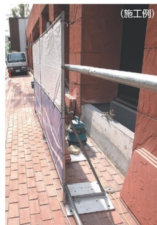
ベースプレートにフェンスバリケード取り付けH鋼の代替品として利用できます。
