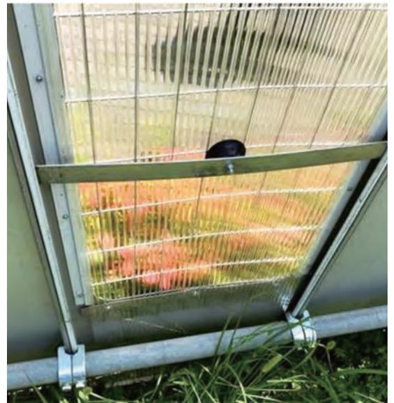
裏面は押さえ板でポリカ板を固定していますが外すとメッシュパネルに早変わり。状況に応じて仮囲いを入れ替えることなく強風対策ができます。
