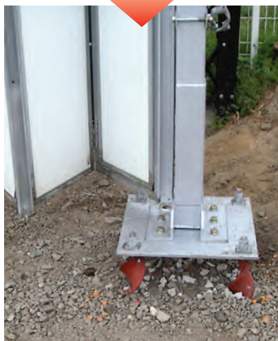
各部材取り付け
