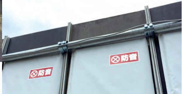
「NKタウンキャンバス2型」は、1型と遮音シートを組み合わせたシート状制振材。
