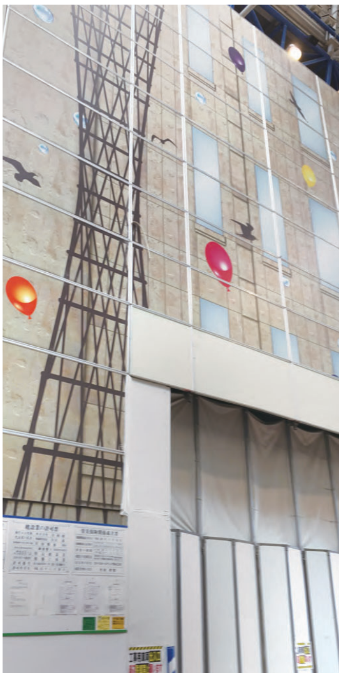
防音パネルにもデザイン施工
