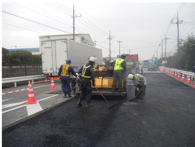
舗装施工現場作業風景
