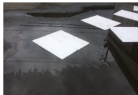
流出した油の回収作業
