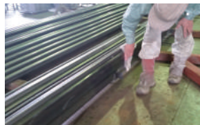
機械油や鉄骨の油拭き取り
