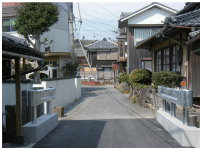
舗装・ガードレール設置完了
