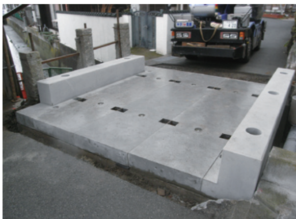
床版施工完了
