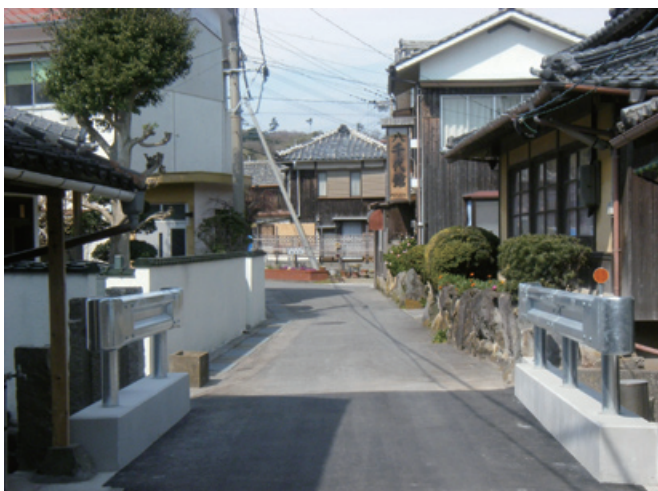
舗装・ガードレール設置完了
