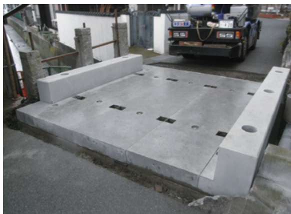
床版施工完了
