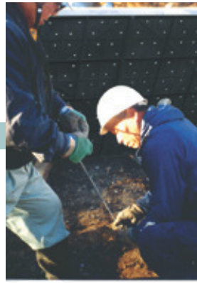
3 KCパネル固定ナットの取付け
