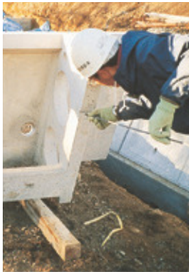
1 セパレーターの取付け
