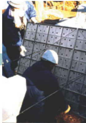
2 KCパネルの取付け
