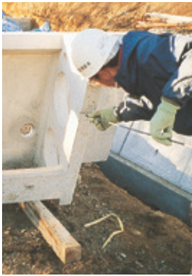
1 セパレーターの取付け
