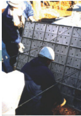
2 KCパネルの取付け
