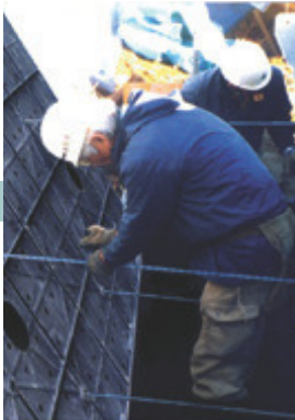
5] KCパネルの固定
