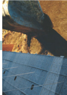
6] 裏込材料の投入
