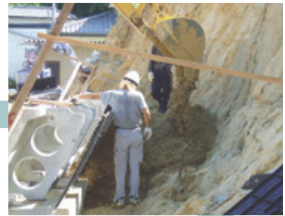
3 裏込材料の投入
