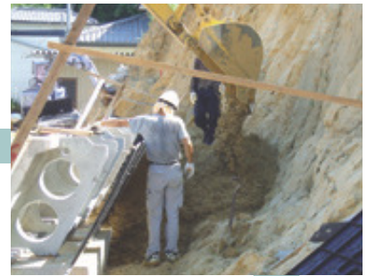
3 裏込材料の投入
