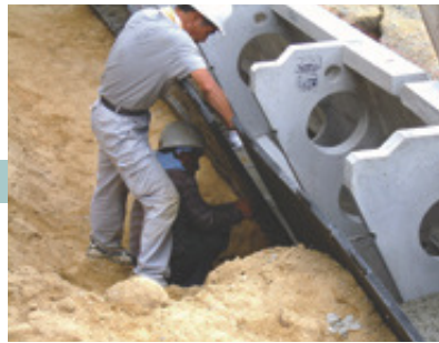
2 KCパネルの固定
