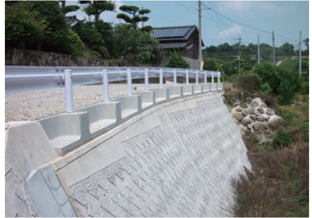
ブロック積み擁壁
