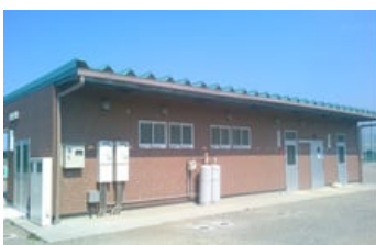
サッカー場の管理棟施設です。
