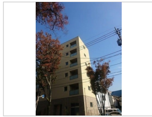
大田区 RC造6階 共同住宅 12戸
