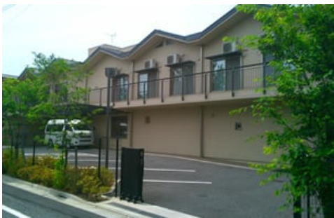
練馬区 サービス付高齢者住宅
