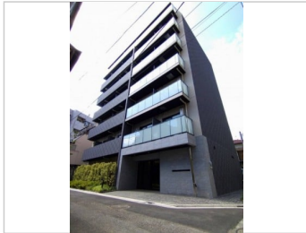
足立区 39戸マンション
