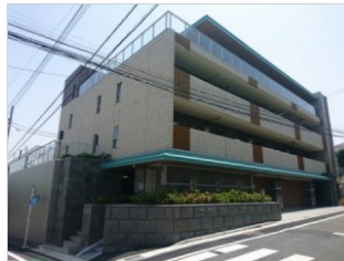
大田区 RC造4階 共同住宅 13戸
