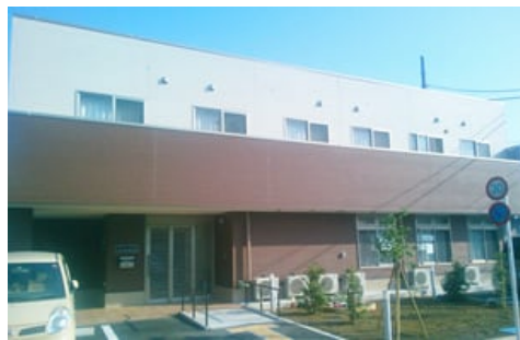
国分寺市 介護施設
