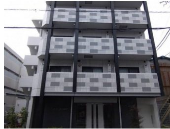
大田区 共同住宅WRC造5階 31戸
