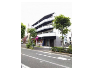
大田区 RC造4階 共同住宅 18戸
