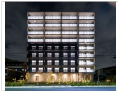
墨田区 RC造9階 共同住宅 99戸
