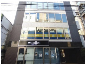
国分寺市 共同住宅S造4階
