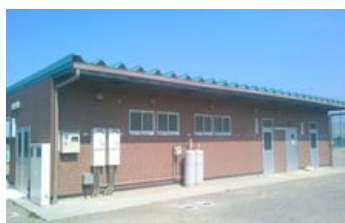
サッカー場の管理棟施設です。
