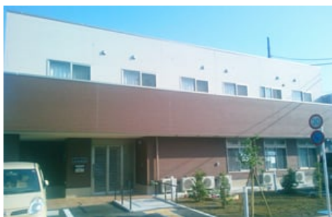
国分寺市 介護施設
