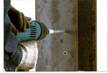
③ ねじ込み作業 先端工具(別売品)を装着したインパクトレンチを使用しスクリューギアを下穴にねじ込む。 注：ねじ込みすぎないようにご注意ください。
