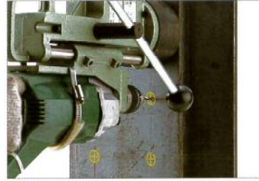
② 穴あけ作業 墨だし位置に電磁式マグネットドリルにてスクリューギアの挿入下穴をあける。 下穴寸法：(7.1φ×12mm)
