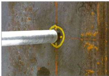
④ 確認作業 ハイパータッピングと母材の定着部の確認を行なう。隙間がないか、ねじ込みすぎているかを確認する。異常がある場合は手直しを行なう。
