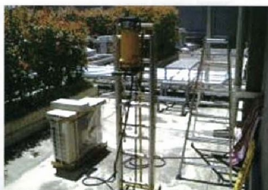
その他、ハツリ工事・鉄筋探査も承ります。
