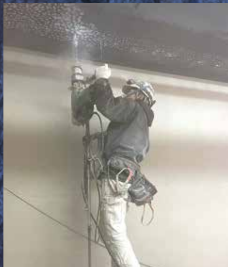
あと施工アンカー工事
