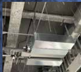
設備機器取付
