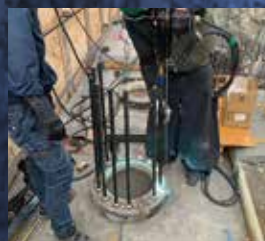
スタッド工事
