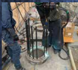
スタッド工事
