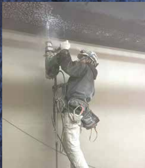
あと施工アンカー工事
