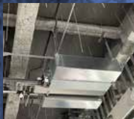
設備機器取付
