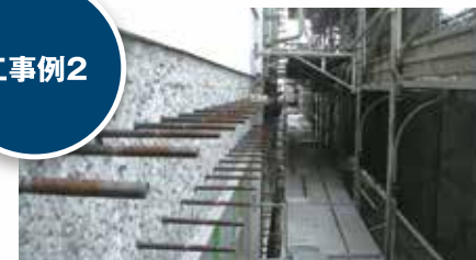
大規模な工事にも対応いたします。
