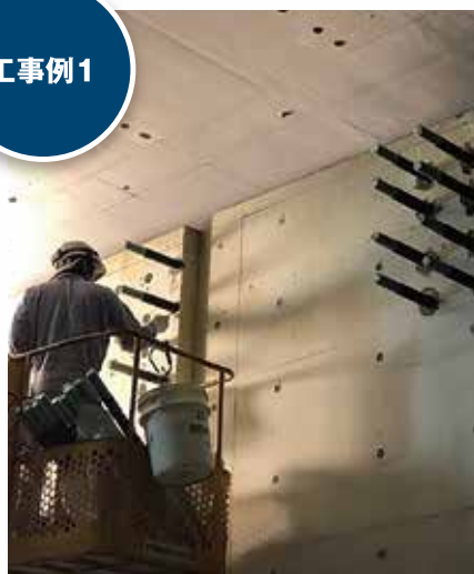
熟練のスタッフが耐震工事を担当します。
