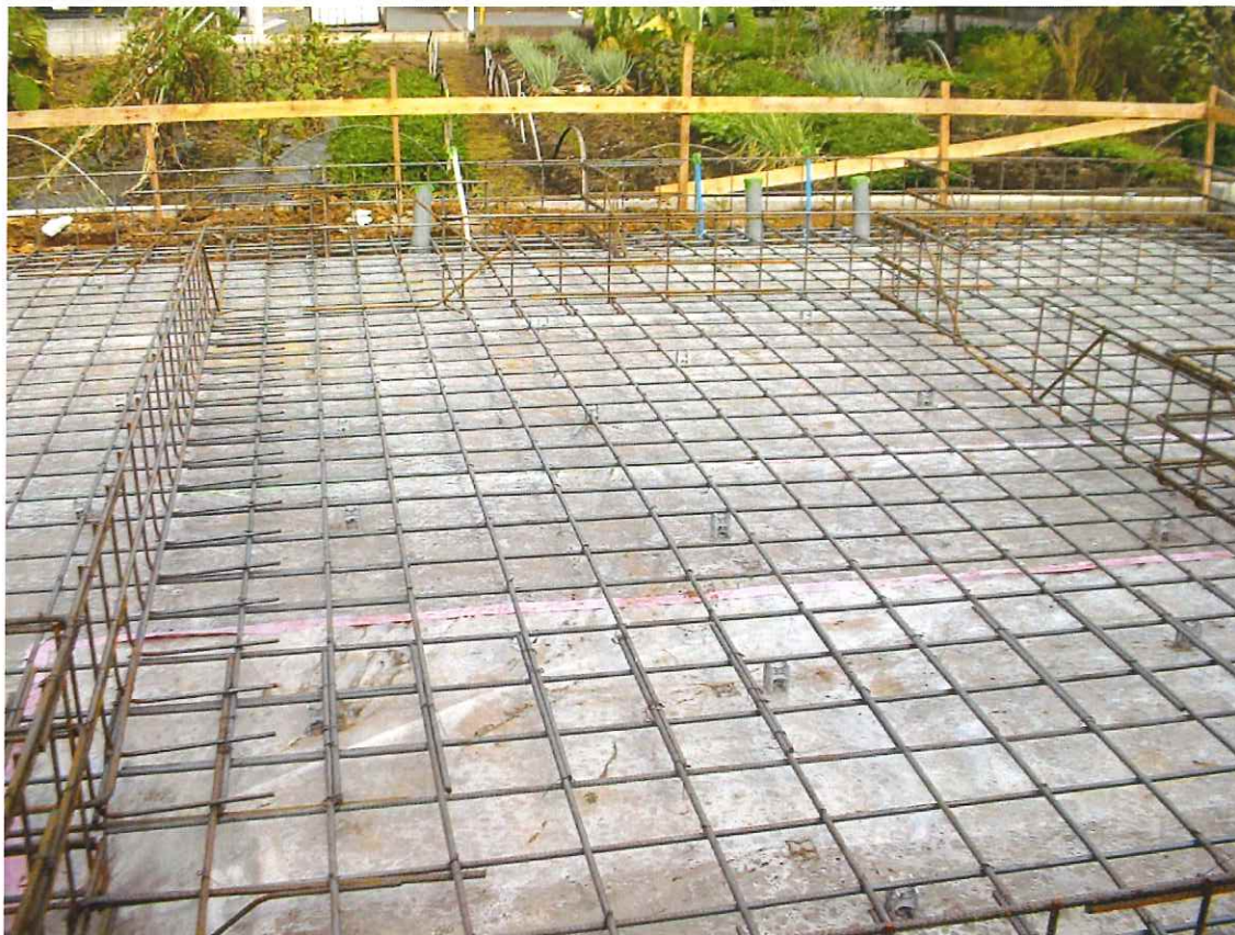
ベタ基礎（立上り基礎巾 150mm）
