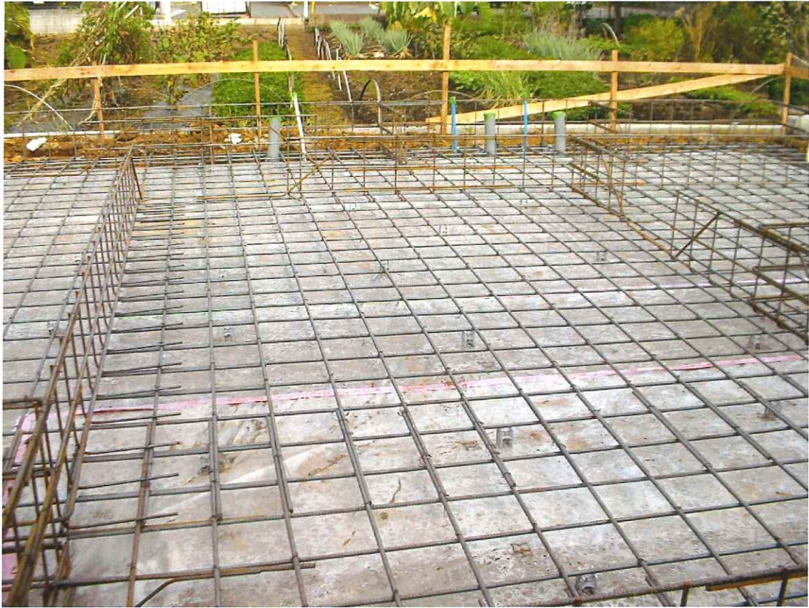
ベタ基礎（立上り基礎巾 150mm）
