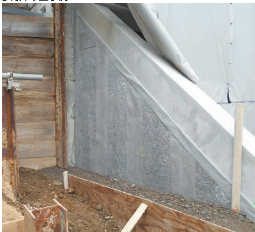
●特殊な工事例
