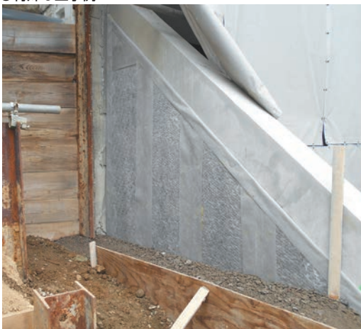
●特殊な工事例
