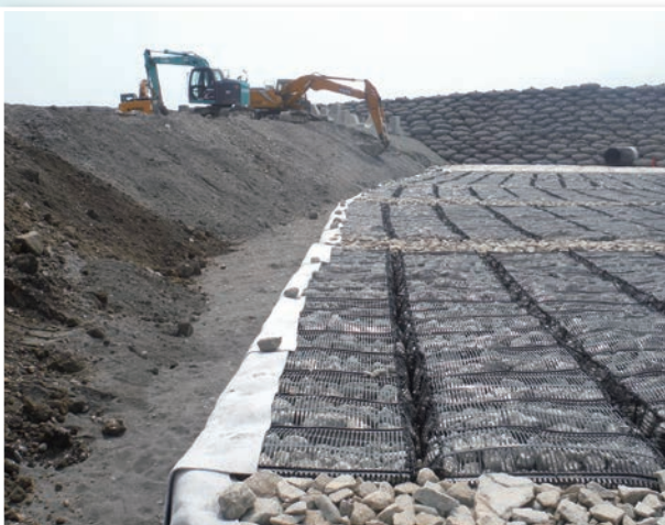
海岸の洗掘・侵食防止 | 工事名:あけぼの地区高潮堤整備工事(和歌山県) 施主:国土交通省 整備局紀南河川国道事務所 新宮出張所
