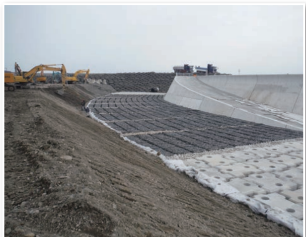
海岸の洗掘・侵食防止 | 工事名:あけぼの地区高潮堤整備工事(和歌山県) 施主:国土交通省 整備局紀南河川国道事務所 新宮出張所
