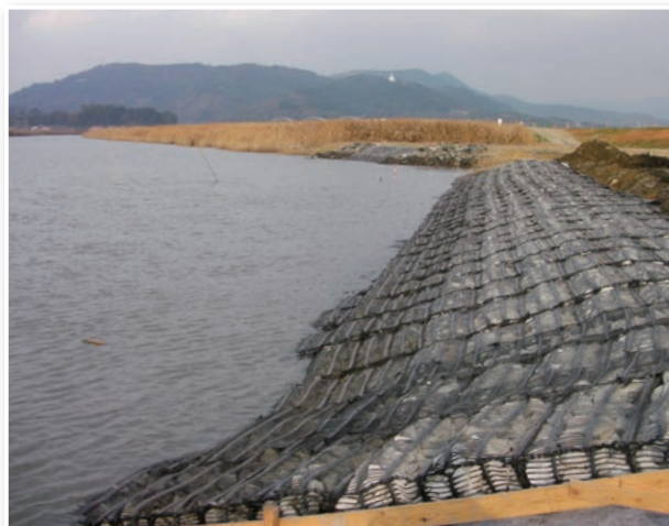
河川護岸の洗掘・侵食防止 | 工事名: 牛津川下流左岸護岸根固災害復旧工事(佐賀県) 施主: 国土交通省 武雄河川事務所
