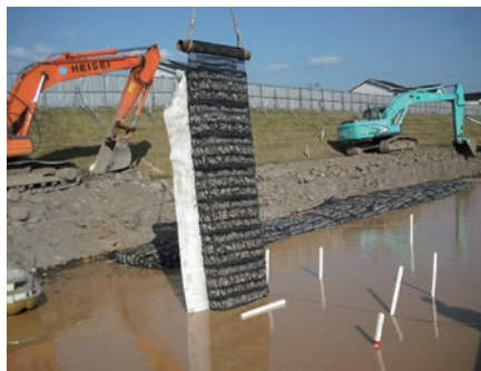
河川 | 堤防の侵食防止
