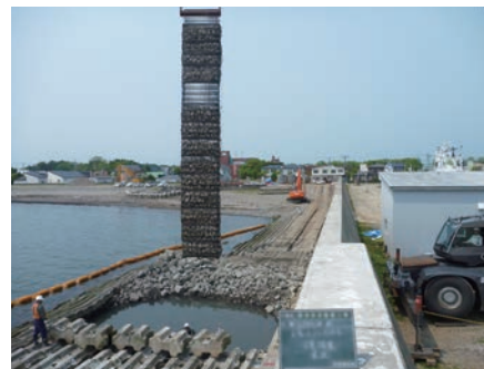
施設 | 急勾配碎石層の構築
