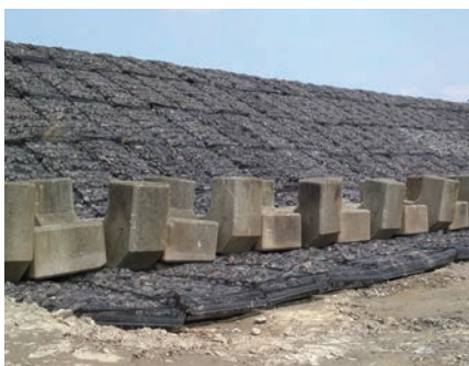
災害復旧 | 決壊堤防の応急対策
