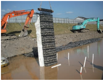
河川 | 堤防の侵食防止
