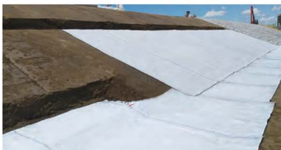
河川護岸(川裏)
