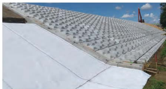
河川護岸(川裏) ブロック敷設状況
