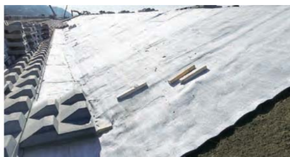
河川護岸(川表) ブロック敷設状況
