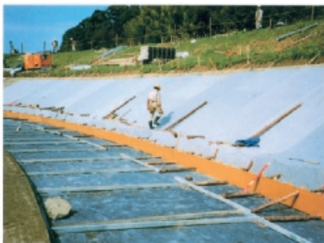
写真3 遮水工の施工状況
