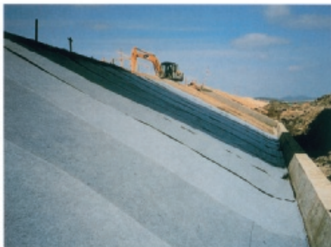
写真1 遮水工の施工状況
