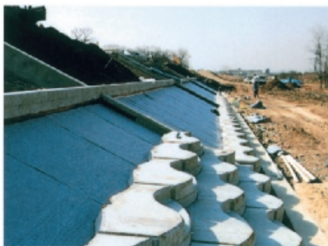
写真6 遮水工の施工状況
