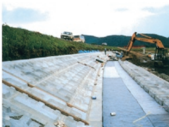
写真4 遮水工の施工状況
