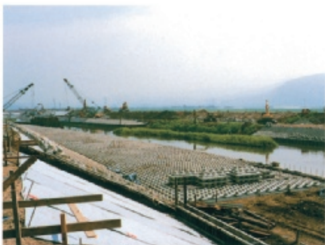
写真5 遮水工の施工状況
