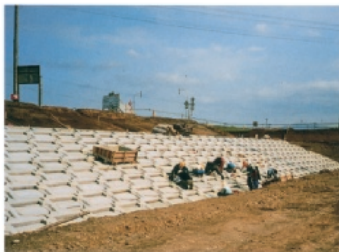
写真2 遮水工の施工状況
