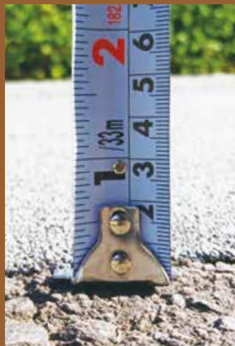
施工完了厚さ
