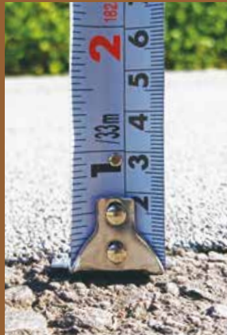
施工完了厚さ
