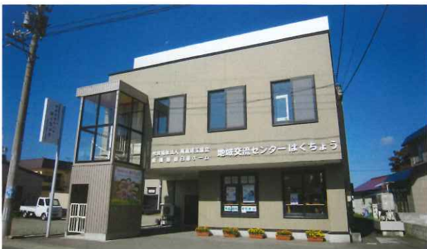
町内に設置された「地域交流センターはくちょう」
