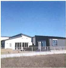
新しくできた離れ。 (写真は完成間近の様子)
