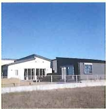
新しくできた離れ。 (写真は完成間近の様子)
