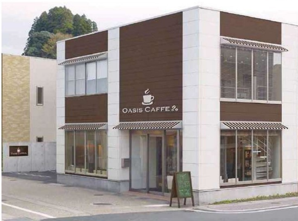
カフェバイザーれいわ施工後 (特殊フィルム塗装付)
