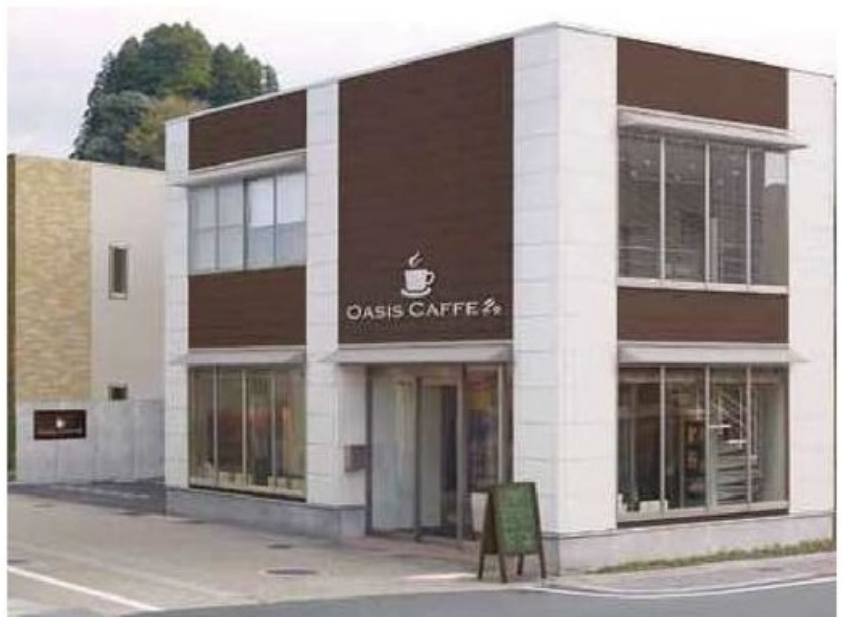
へいせいマークII施工後
