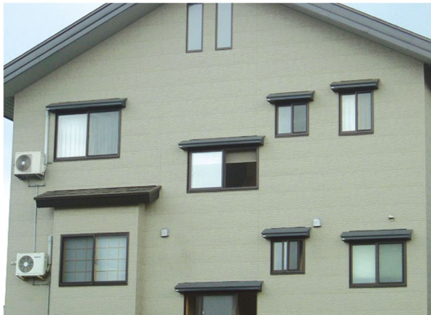
【へいせい施工例】
