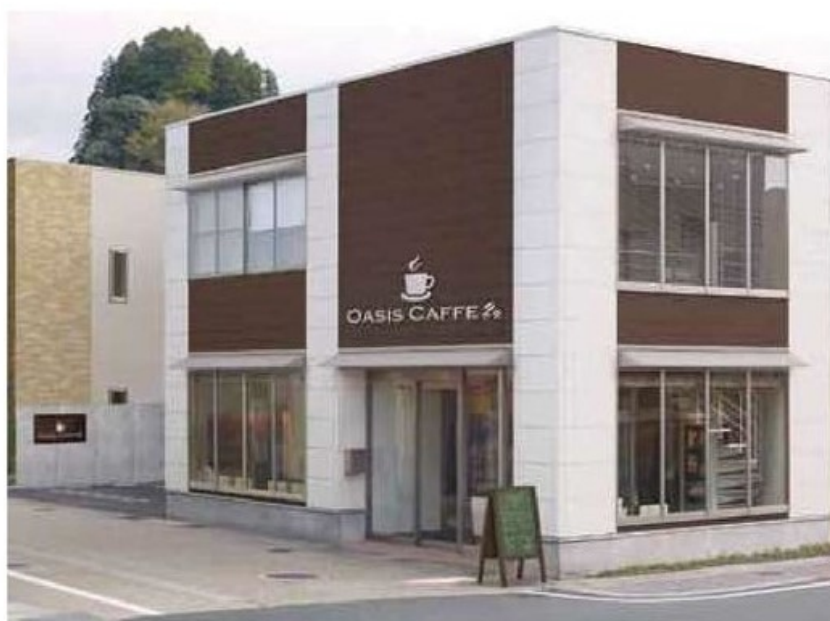
へいせいマークⅡ施工後
