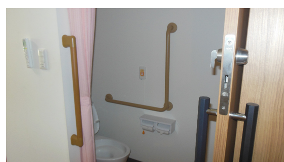
居室内トイレ
