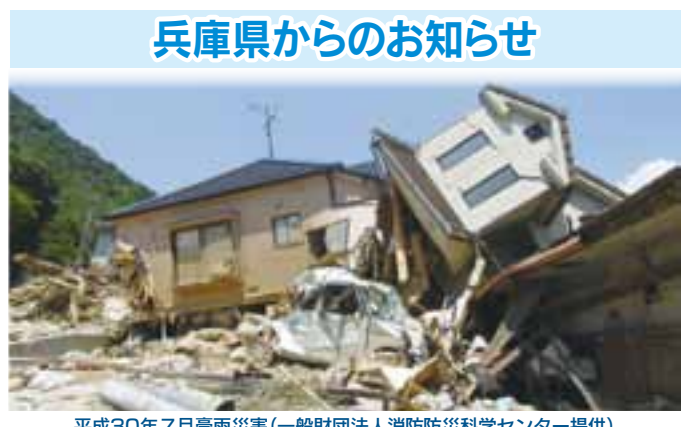
平成30年7月豪雨災害(一般財団法人消防防災科学センター提供)
