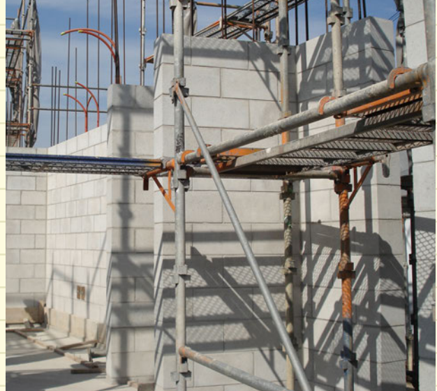
CP型枠ブロック建築施工
