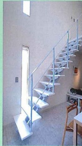
casa cubeオリジナルの鉄骨階段です。
