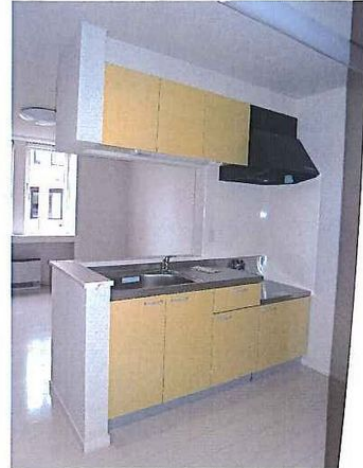
流し台・レンジフード・吊り戸棚
