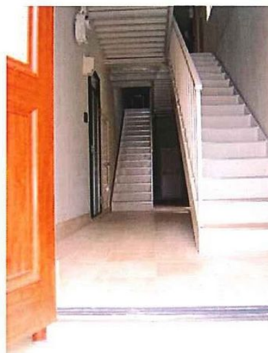
建物内部階段
