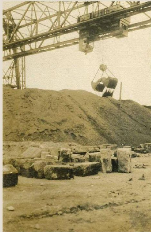
露天掘の様子？
