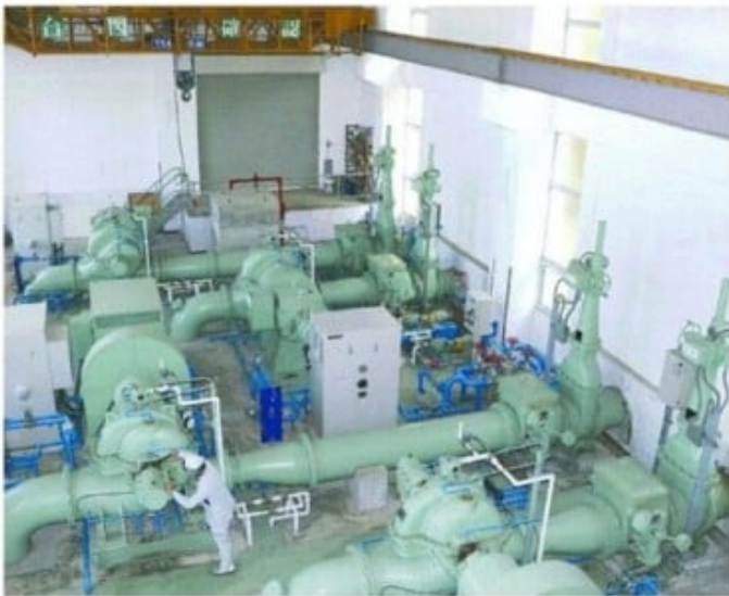
コバリキがポンプ4台の更新工事を行った揚水機場。一帯の田んぼへ配水し米作りを支える＝南魚沼市
