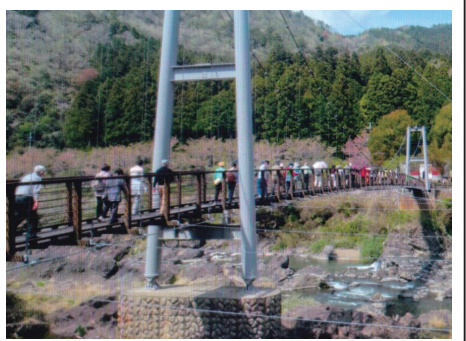
全長90mの吊り橋
