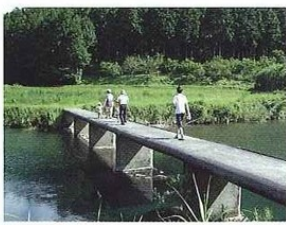
③ 高樋沈下橋 四万十川最上流にかかる沈下橋 ☎ 0889-52-2473 (中土佐町水産商工課)
