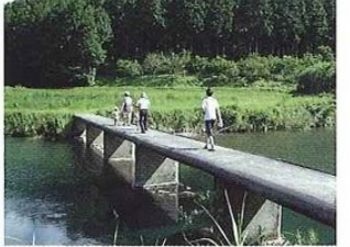
③ 高樋沈下橋 四万十川最上流にかかる沈下橋 ☎0889-52-2473 (中土佐町水産商工課)
