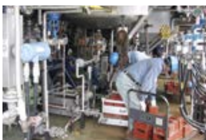
タンクスケール定期点検
