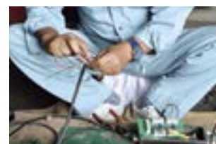
ケーブル修理
