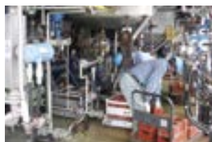
タンクスケール定期点検
