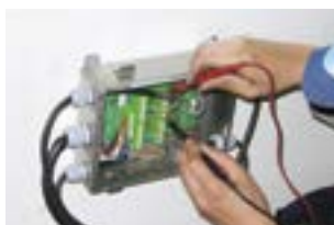
ロードセル定期点検
